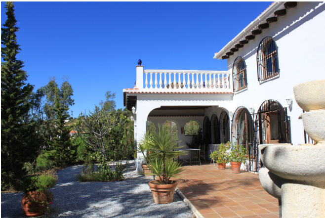
Terrasse Sud, couverte, RDC
